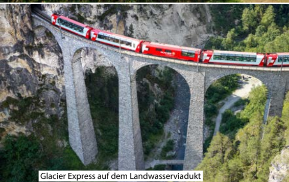
Glacier Express auf dem Landwasserviadukt
